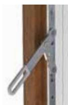
Poignée de manoeuvre anti-effraction sur vantail semi-fixe
