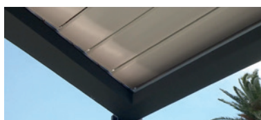
Aspect toit plat sous la pergola avec lames inclinées pour un meilleur écoulement des eaux
