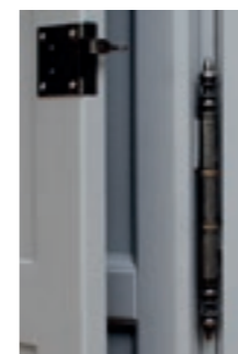
Paumelle turlupet à plaque vissée pour la fenêtre et le volet intérieur
